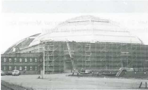
Abb. 23: Ansicht einer Hallenkuppel mit ca. 80 m Spannweite
