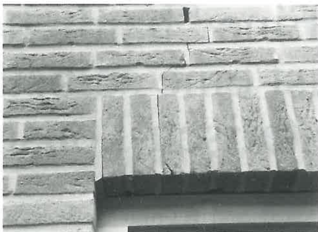
Abb. 7 und 8: Beginn der Rissebildung im Verblendmauerwerk über dem Randbalken (Pos. 41, Abb. 2).
