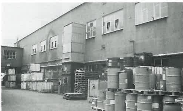
Abb. 15: Gebäudeansicht des Stahlbetonskelettbbaus mit Verblendung
