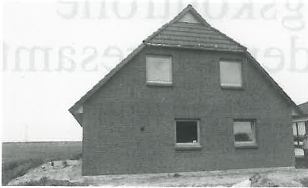
Abb 1.: Nicht unterkellert, Erdgeschoßdecke massiv, Dachgeschoß ausgebaut: das Einfamilienhaus auf problematischem Baugrund
