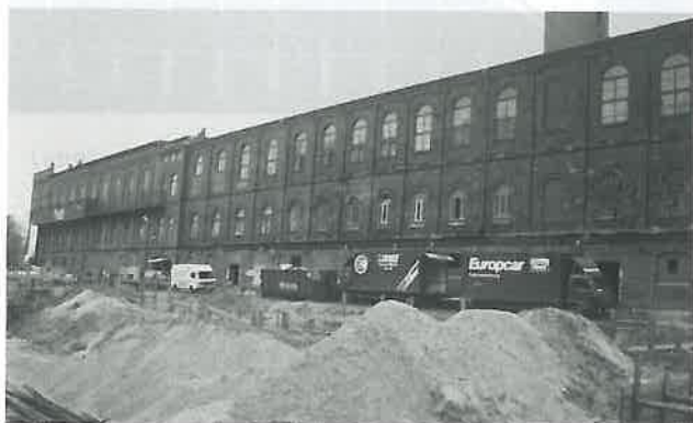
Abb. 39: Ansicht des Gebäudes
