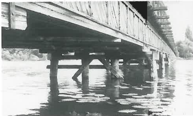
Abb. 44: Seitenansicht der äußeren Hauptträger
