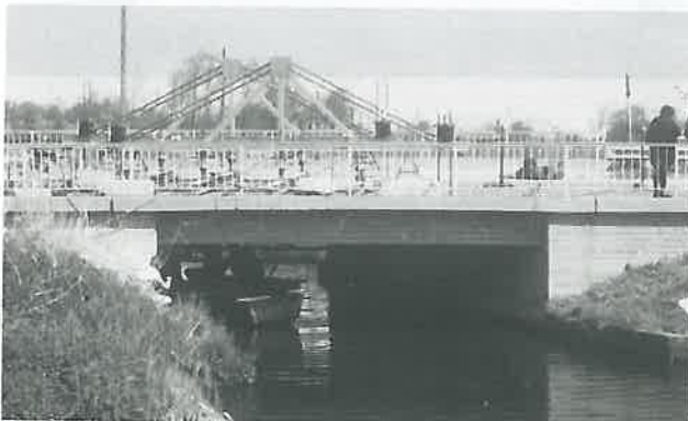
Abb. 19: Brückenansicht mit Testlastgeschirr
