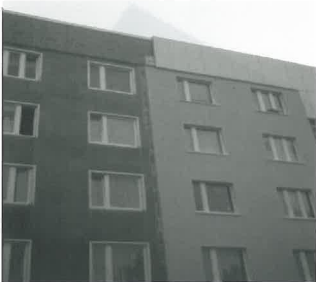
Abb. 9: Verkleidung einer montierten Außenwand mit einer Thermohaut
