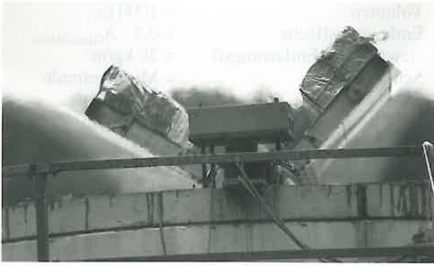
Abb. 13: Klappenkonstruktion bei einer Gasexplosion
