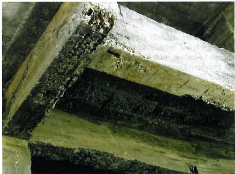
Ausgeschaltete Decken- und Unterzugsbeton im fertiggestellten Wohnungsbau! So haftet der Putz besser!
