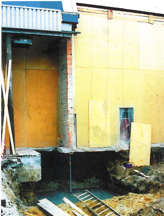
„Unterstützung“ einer Gebäudeecke im Zuge einer Unterfahung
