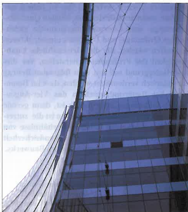
Abb. 15: Seilnetz für Screenwall im SONY-Center Berlin
