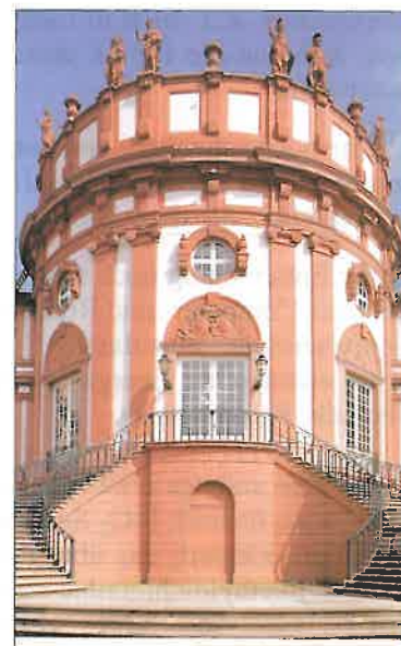
Abb. 11: Ein Barock-Schloß in Wiesbaden: Beispiel für die silikontechnische Wiederherstellung und den Schutz von verwitterten Gebäuden.
