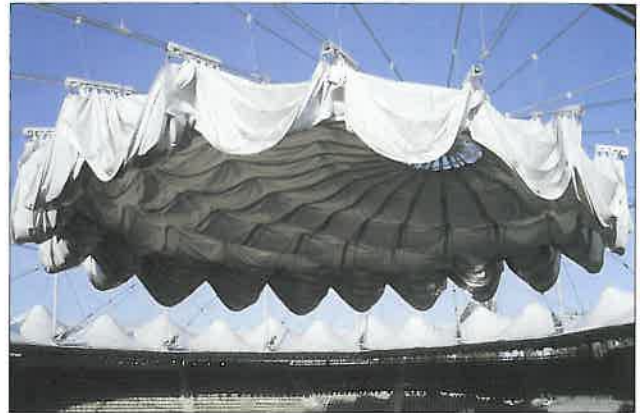
Abb. 12: Wandelbares Membrandach während des Schließvorgangs
