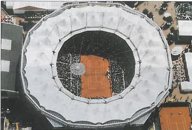
Abb. 10: Tennisanlage Rothenbaum mit einem festen und einem offenen Membrandach
