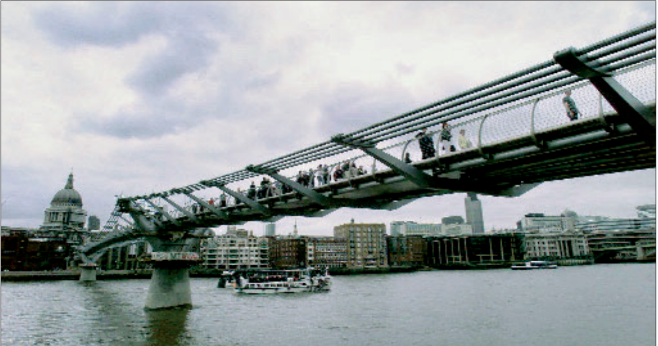
Die Millenniumbrücke in London, bei der unter dem großen Besucherandrang am Eröffnungstag starke seitliche Schwankungen auftraten. Die Amplituden waren wesentlich größer als erwartet, was einen Hinweis auf zusätzliche Beiträge aus einer Wechselwirkung zwischen Fußgängern und Brücke lieferte.
