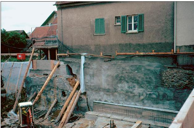
Abb. 8: Teileinsturz eines Nachbarhauses mit Gewölbekeller
