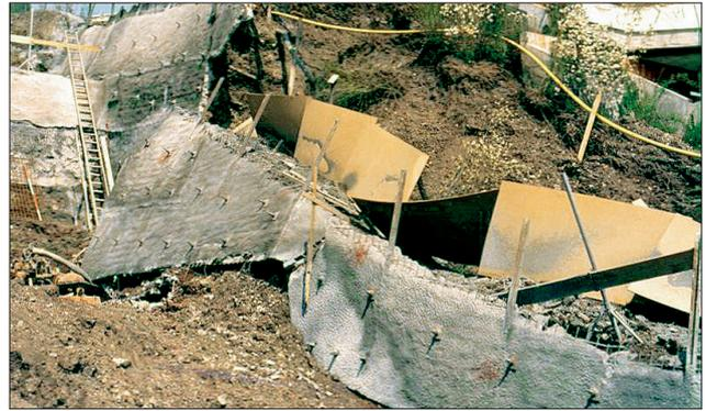
Abb. 9: Baugrubensicherung mit Vernagelung nach dem Einsturz
