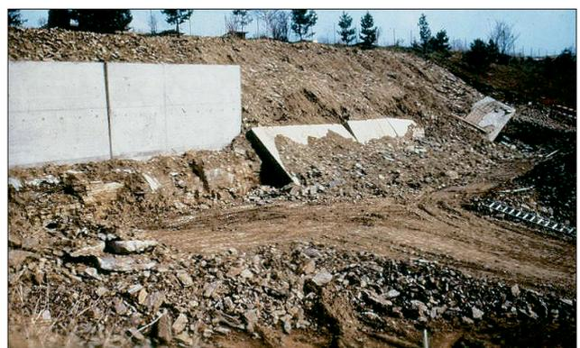
Abb. 10: Eingestürzte Winkelstützmauer
