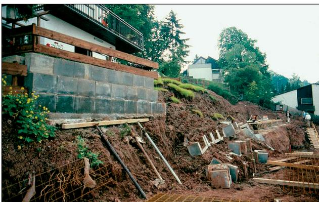
Abb. 7: Eingestürzte Baugrube mit Schädigung des Nachbargrundstücks
