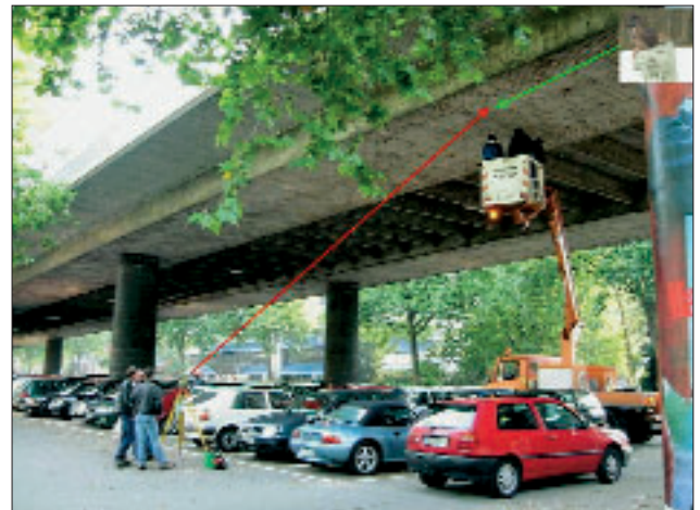
Abb. 4: Georeferenzierung mittels Tachymeters an der Theodor-Heuss-Brücke in Düsseldorf
