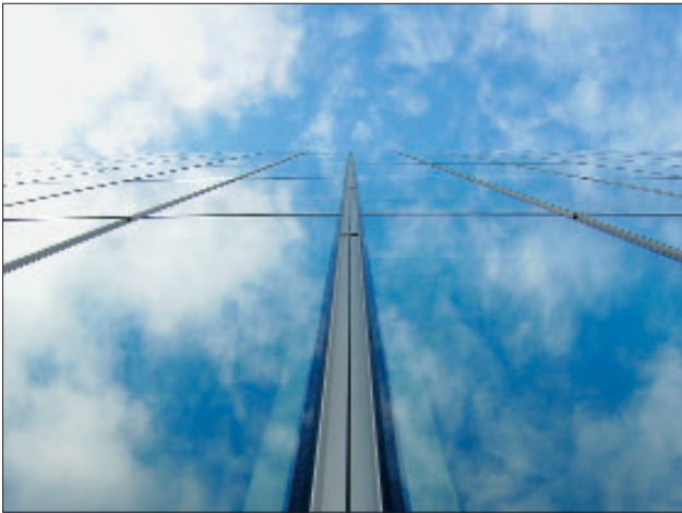
Abb. 3: Structural Glazing Fassade des BBC Scotland Headquarters, Architekten: David Chipperfield Architects. © Institut für Baukonstruktion, Technische Universität Dresden
