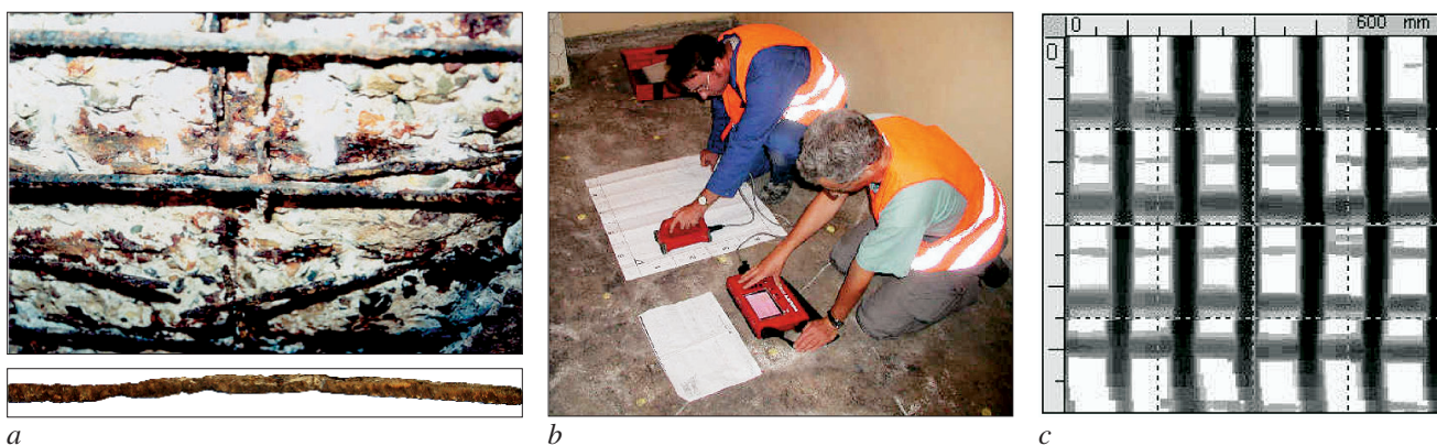
Abb. 2 (a): Typisches Schadensbild chloridinduzierter Lochfraßkorrosion durch Tausalz in Verbindung mit zu geringer Betondeckung; (b): Betondeckungsmessgerät im Einsatz; (c): Bildgebende Darstellung der Bewehrung und deren Tiefenlage
