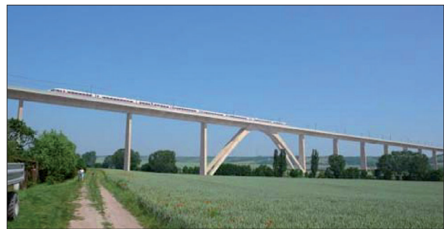
Abb. 5.1 b: Unstrutt-Talbrücke, z.Zt. im Bau (Quelle: DB AG)
