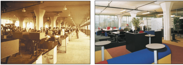
Bild 6: Fabrik van Nelle in Rotterdam, die Niederlande: links als kaffeeverarbeitende Firma im Jahre 1920 und rechts als modernes Bürogebäude im Jahr 2010
