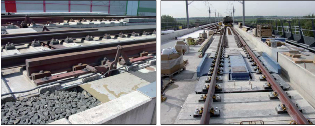
Abb. 4.5: Traversenkonstruktion BWG (links) und STOG-Ausgleichsplatten (rechts)
