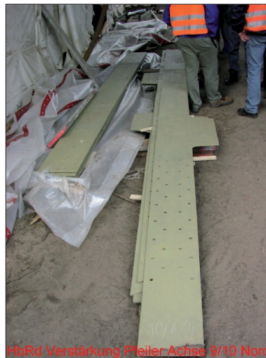
Abb. 12: Verstärkung von Fachwerkstäben der Gerüstpfeiler durch Aufschauben von Lamellen
