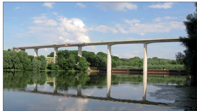
Abb. 5.1 a: Scherkondetalbrücke (Quelle: DB AG)
