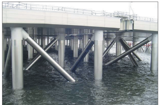
Abb. 3: Plattform im Meer für die neue Start- und Landebahn des Haneda Flughafens in Tokyo, Japan
