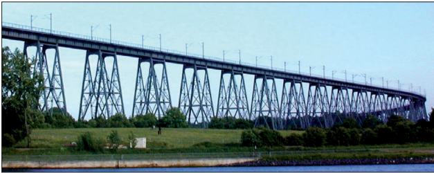
Abb. 9: Ansicht der südlichen Rampenbrücke der Eisenbahnhochbrücke Rendsburg
