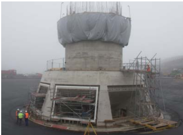
Abb. 5: Einlaufsturm auf einem Trichter mit circa 70 Meter Durchmesser; Schaftherstellung in Gleitbauweise
