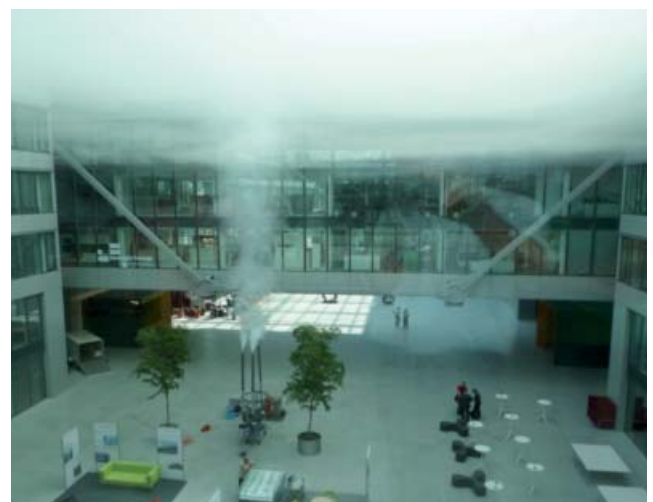
Abb. 3: Rauchversuch im Atrium von „The Squaire“ mit einer Brücke als Rauchschiürze
