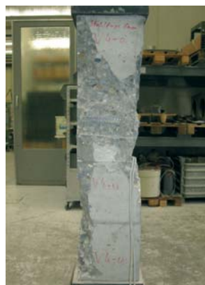
Abb. 11: Versagen der Stützen bei einer Dicke der „Stahlfuge“ von 6 mm (V4),
