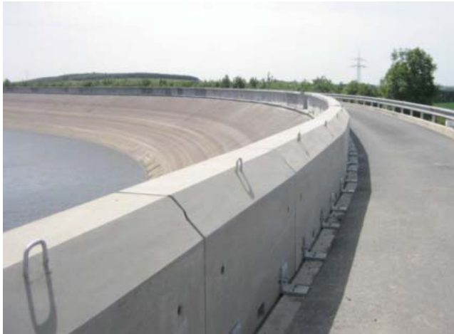
Abb. 4: Neue Dammkrone mit den Stahlbetonfertigteilen der Wellenschutzwand
