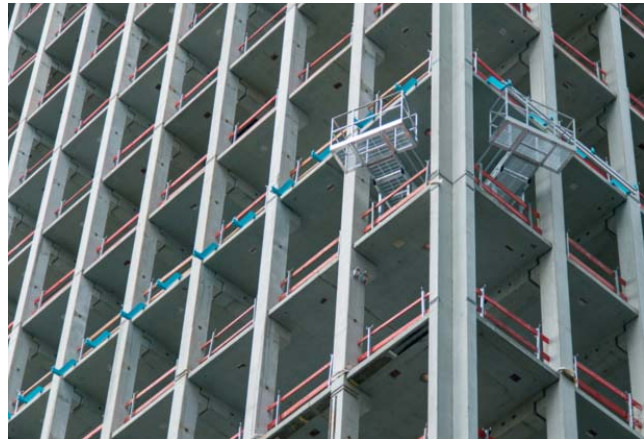
Abb. 33: Fertiggestellte Rohbaukonstruktion beim Taunusturm in Frankfurt
