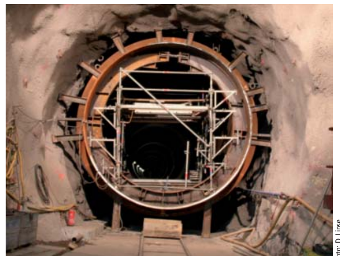
Abb. 8: Druckrohre (Druckstollen) vor dem Einbetonieren
