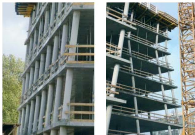
Abb. 22: Die Tanzenden Türme im Bauzustand
