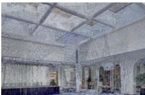
Abb. 13: 3D-Laserscan einer Trägerrostkonstruktion
