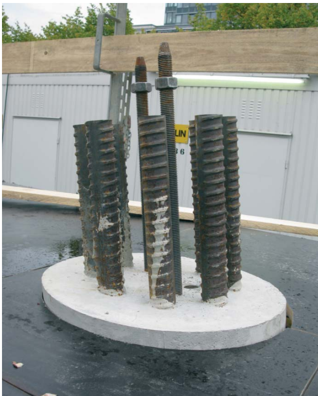
Abb. 16: Ausbildung des Stützenstoßes im Deckenbereich
