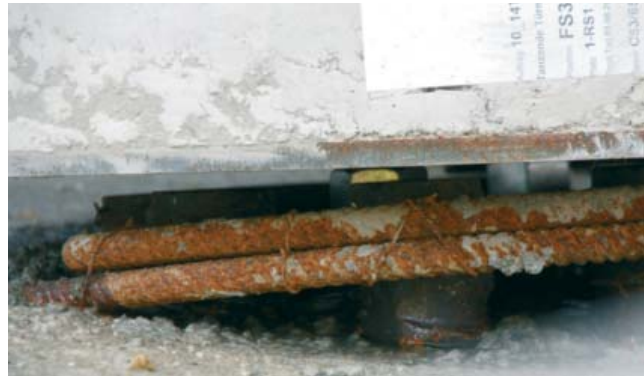
Abb. 17: Ausbildung der Vergussfuge oberhalb der Decke
