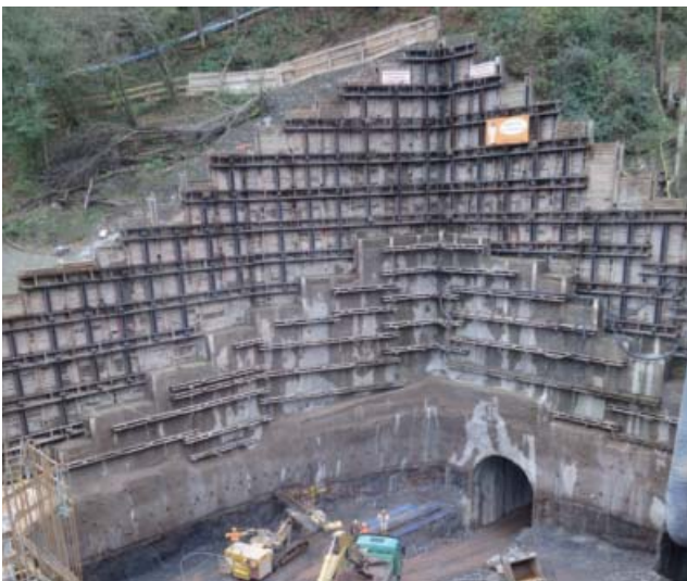
Abb. 13: Baugrubenverbau (Höhe bis zu 34 Meter)
