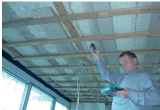
Abb. 12: Zerstörungsfreie Messung der Betondeckung an einer Stahlbetonrippendecke mit dem Bewehrungssuchgerät Proceq-Profometer 5+
