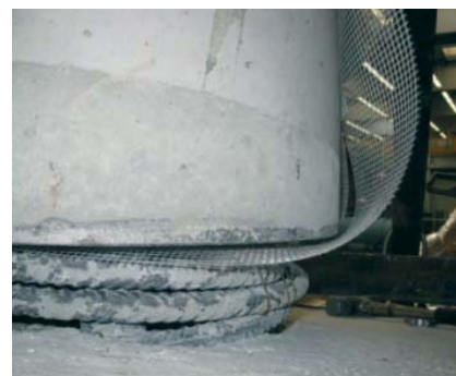
Abb. 21: Vergussfuge mit Gewebeeinlage
