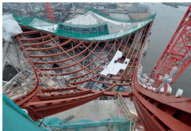
Abb:18: Dachfläche 5 mit dem Beginn der Trapezblecharbeiten
