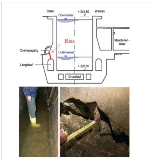
Abb. 2: Querschnitt der Schleuse Bamberg (oben) und überfluteter Dränagegang mit Detaildarstellung der gerissenen Bewehrung (unten)
