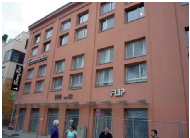
Abb. 8 a: Situation nach der Sprengung: zerbrochene Fenster, die mit Folie notdürftig geflickt worden sind
