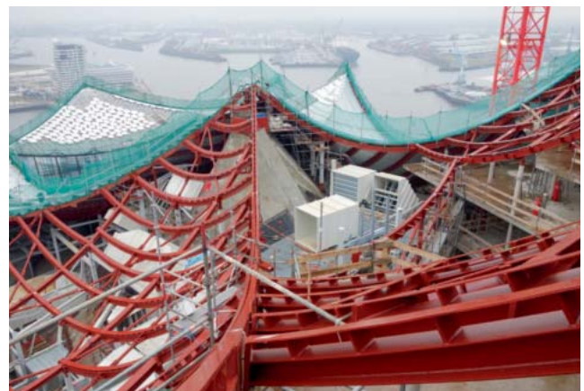
Abb: 21: Dachflächen 3 und 6 mit den abgeschlossenen Schweißarbeiten am Zentralpeak
