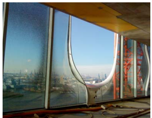
Abb. 5: Fassadenelemente der Südfassade (Loggia im Foyerbereich)
