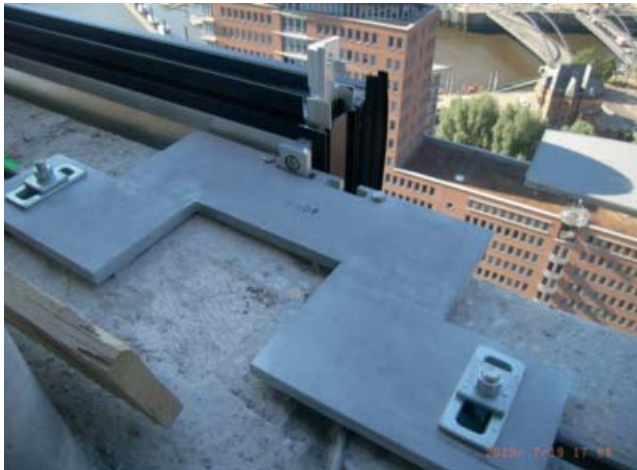
Abb. 6: Fassadenbefestigung an der Betonkonstruktion
