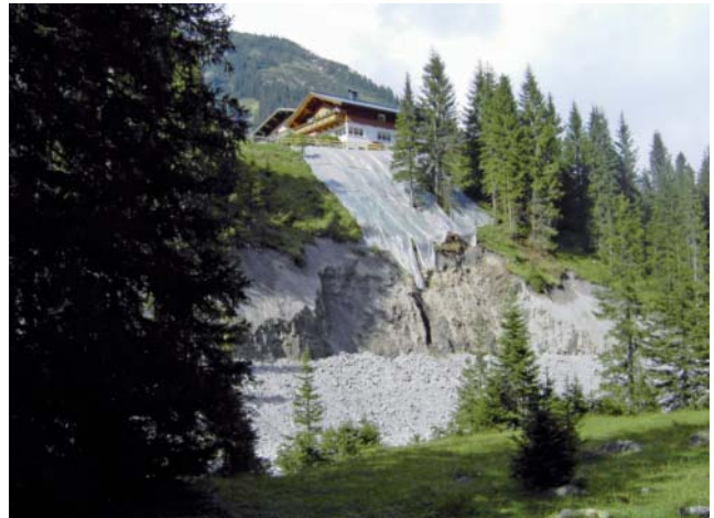
Abb. 4 a.: Hangrutsch, Folienschutz
