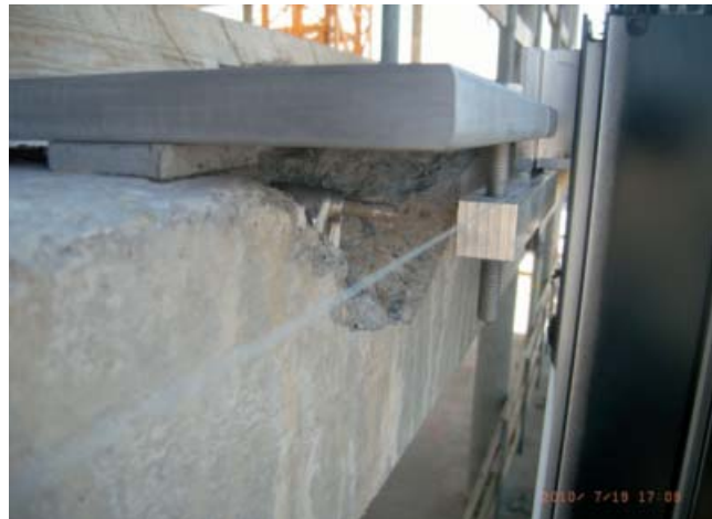
Abb. 7: Justierung der Lagerpunkte des Scheibenelementes
