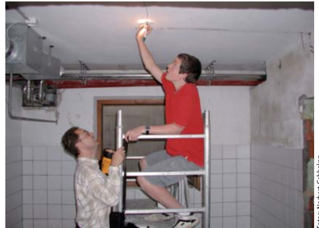
Abb. 5 b: Inspektion und Vermessung von Rissen im Beton
