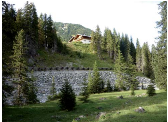
Abb 4 b: Hangstabilisierung und Wildbachverbau
