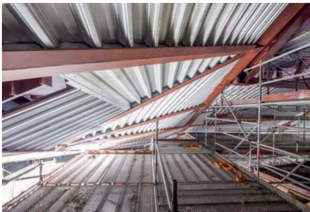
Abb. 14: Unterseite der Innenschale mit abgewinkelten Untergurten und den Gerüsten für die Trägermontage
