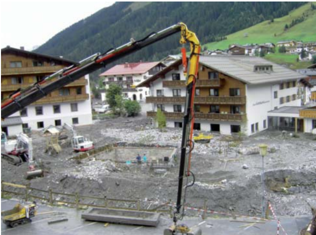
Abb. 5a: 1,35 Meter Geschiebe auf einer Tiefgaragendecke
