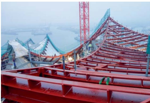
Abb: 20: Dachfläche 2, im Hintergrund die Spitzen der Dachflächen 5 und 7 sowie der eingehauste Zentralpeak
