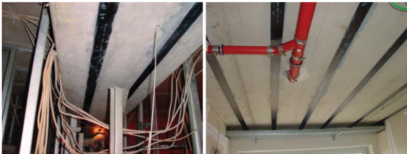
Abb. 11: Eingebaute Verstärkung mit CFK-Lamellen als äußere Bewehrung – links: Unterzug; rechts: Deckenplatte
