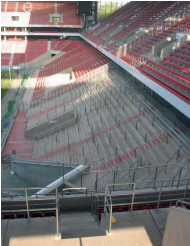
Abb. 3: Stehplatzbereich Nord beziehungsweise Stehplatzbereich Gäste im Unterrang des RheinEnergiestadions Köln
