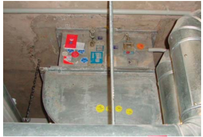
Abb. 4: Einbau einer Brandschutzklappe in eine mit Naturbrandkurve nachgewiesene Decke
