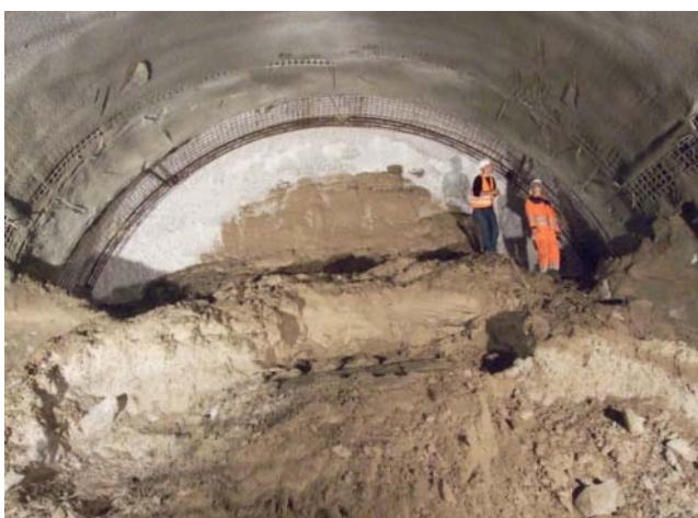
Abb. 4: Ein schneller Vortrieb ist möglich, weil die Sicherung und Abdichtung durch den Frostkörper vorab bereits erledigt werden.
