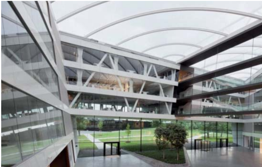
Abb. 4: Applikation eines RBS in einem Bürogebäude (Adidas Laces, Herzogenaurach, 2011): Blick aus dem Atrium auf das mehrstöckige Stahltragwerk (links) und teilbeschichtete Stahlfachwerkdialagonalen (rechts)
