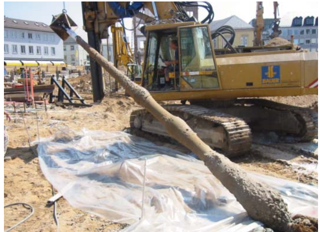
Abb. 12: Auch ungestörte Bodenproben können durch Gefrieren gewonnen werden; dabei wird der Boden um eine Vereisungslanze herum in vorherberechneter Dicke gefroren und die Lanze dann aus dem Boden gezogen.
