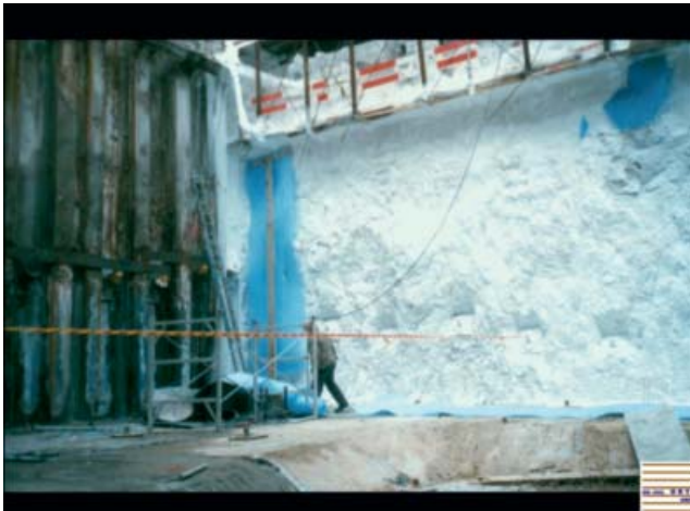
Abb. 10: Verankerte gefrorene Baugrubenwand für den Bau des Rosmarin-Karrees in Berlin
