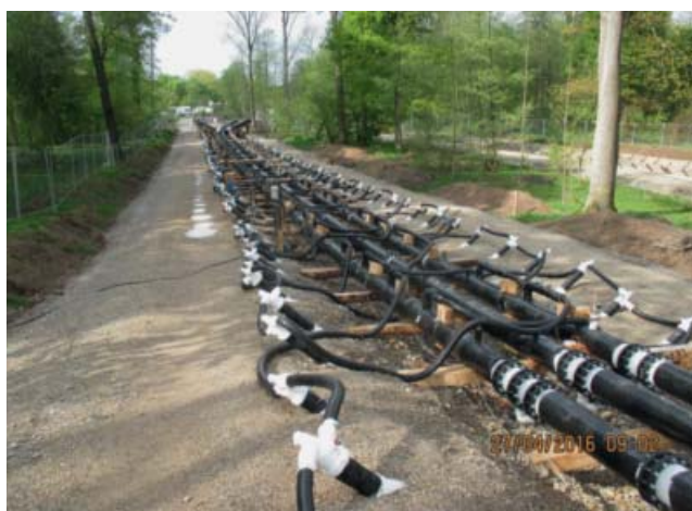
Abb. 9: Beim Bau des Eisenbahntunnels Rastatt reichte die vorhandene Überdeckung der Tunneltrasse für eine Vereisung bereichsweise nicht aus; als Ersatz wird (links) im Untergrund ein dachförmiger Frostkörper erstellt, der die Auftriebskräfte in tiefere Bereiche einleitet; für die Bemessung der Einwirkungen auf das Frostdach, müssen alle Belastungen exakt berücksichtigt werden (rechts).
