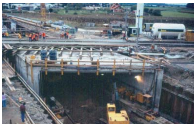
Abb. 8: Die Stabilisierung dieses Eisenbahndammes wurde unter Verkehr durch Vereisen seitlich von außerhalb des Verkehrsraumes ausgeführt (rechts); die Eisplatte muss dabei aber dem Vortrieb folgend sukzessive abgebrochen werden (unten).
