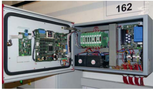
Abb. 6: Geöffnete Brandmelde-Unterzentrale
