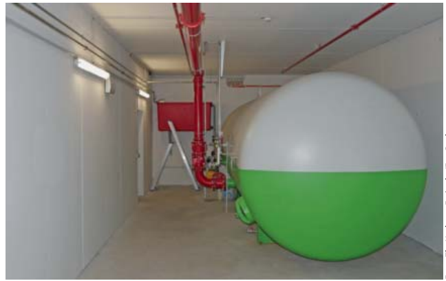
Abb. 3: Druckluftwasserbehälter einer Sprinkleranlage
