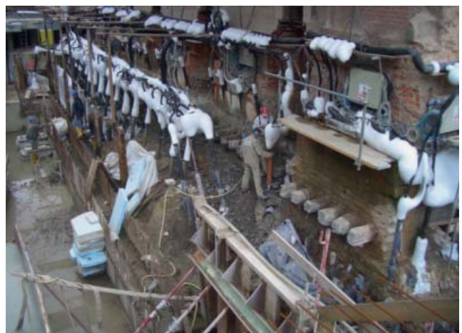
Abb. 7: Es kann – wie hier unter dem Berliner Museum – zweckmäßig sein, den Frostkörper auf Pfähle zu gründen; dies erfordert allerdings eine genaue Analyse des Tragverhaltens sowohl der Pfähle selbst als auch der Lastübertragung vom Frostkörper auf die Pfähle.
