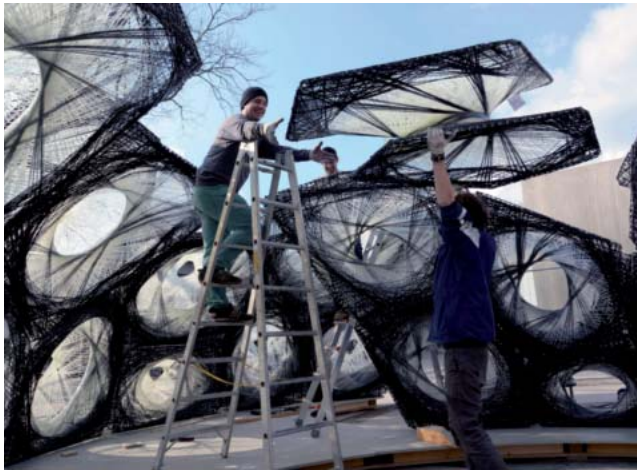
Abb. 5: Montage der 36 verschiedenen Komponenten für ICD/ITKE Forschungspavillon 2013-2014
