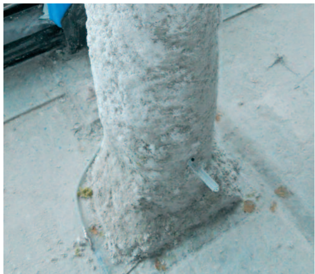
Abb. 10 und Abb. 11: Zughänger mit Mineralfaserspritzputz
