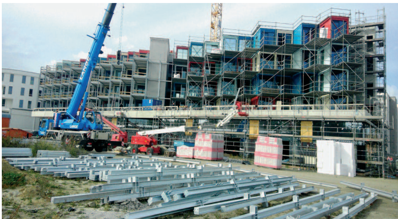
Abb. 1: Stahlbau- und Containermontage des Hostels „DOCK INN Warnemünde“
