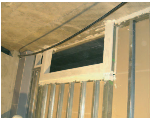
Abb. 18: Auswechslung Brandwand in Trockenbauweise
