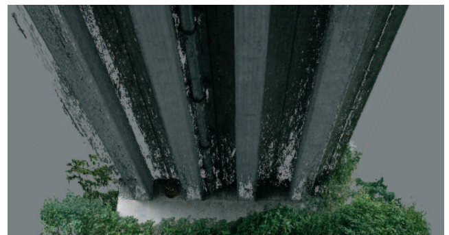
Abb. 8: Photogrammetrische Punktwolke der Unterseite der Betonbrücke bei Ebersbach
