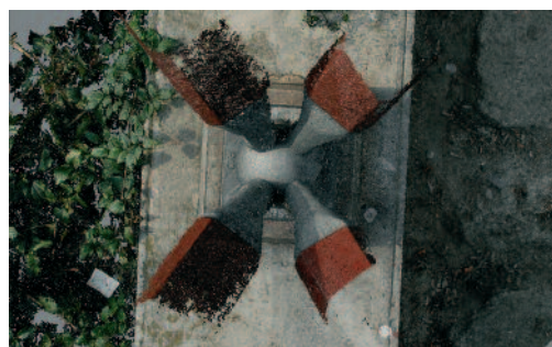
Abb. 5: Photogrammetrisch erzeugte Punktwolke eines Fußpunktes der Thalkirchner Brücke
