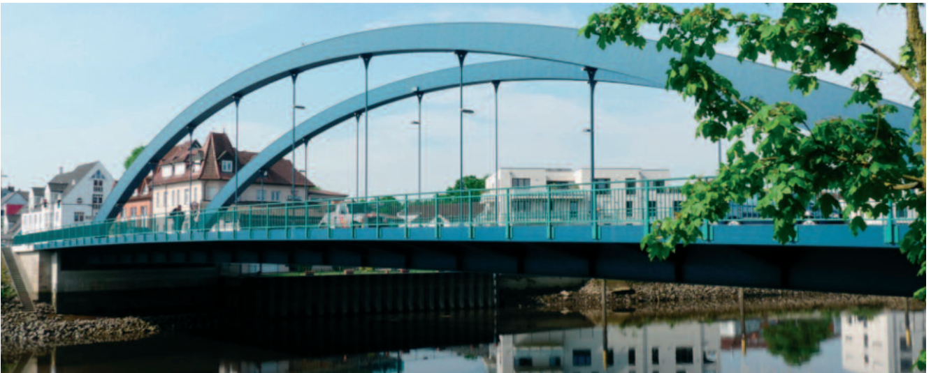
Abb. 29: Stahl-Bogen-Brücke über den Fluss Lesum in Bremen
