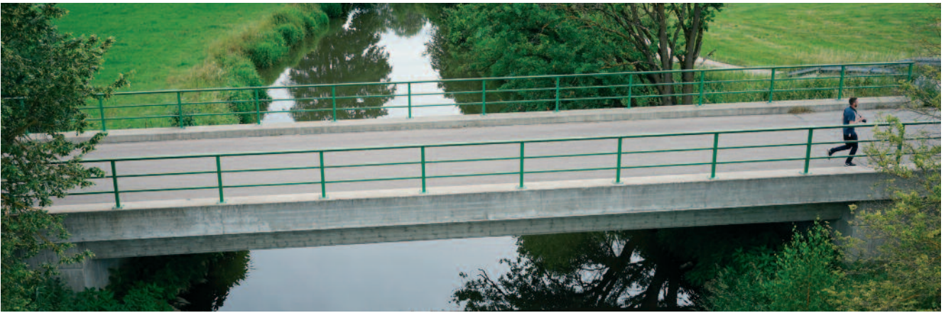
Abb. 6: Betonbrücke über die Glonn bei Ebersbach
