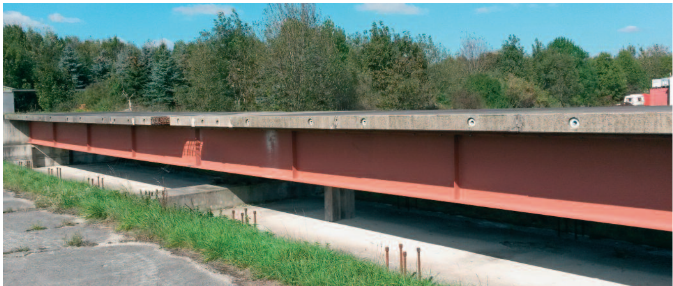
Abb. 9: Versuchsbrücke der Universität der Bundeswehr München
