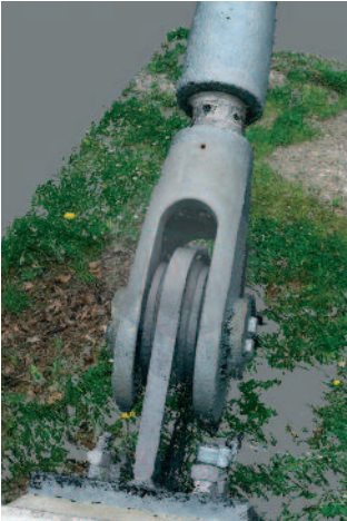
Abb. 19: Verankerungspunkt für die Seilabspannung der Fußgängerbrücke (Abb. 14): links die Punktwolke mit Photogrammetrie und Handkamera, rechts die Realität
