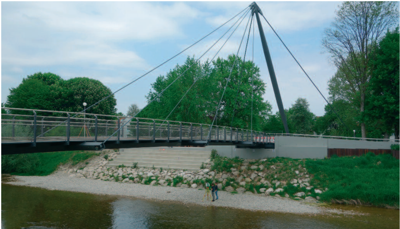
Abb. 14: Fußgängerbrücke in Verbundbauweise über die Mangfall in Kolbermoor
